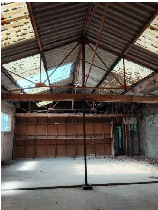
Etage du hangar en structure métallique (4)
