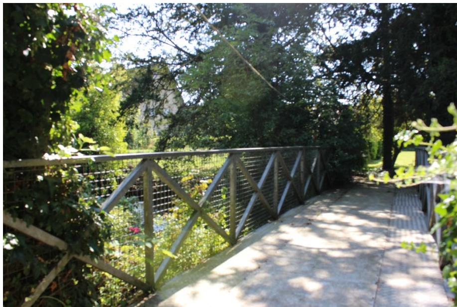
Passerelle reliant le site Courcy aux berges Sud de l'Authie © Urbanova
