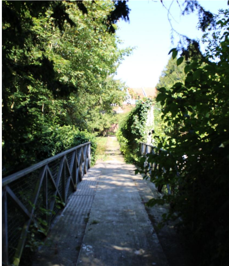
Passerelle reliant le site Courcy aux berges Sud de l'Authie © Urbanova
